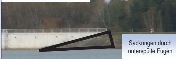
Erneuerung Wasserbaupflaster
